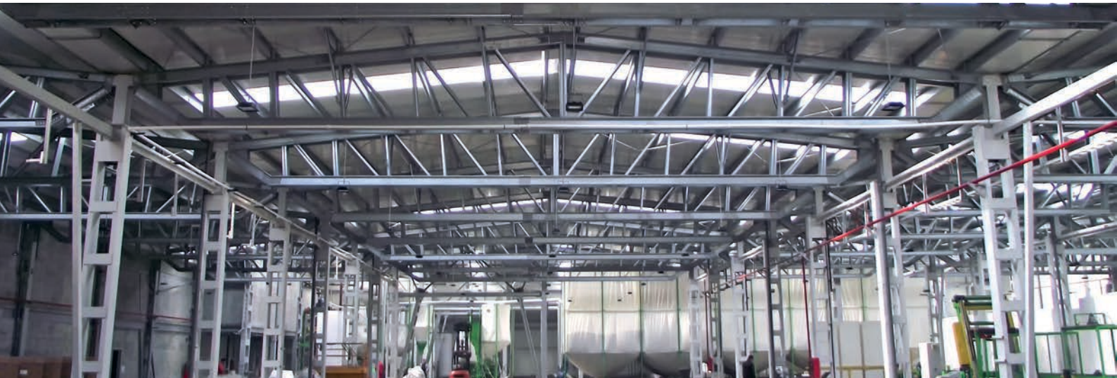
Hală depozit Rm. Vâlcea - 3150 mp
